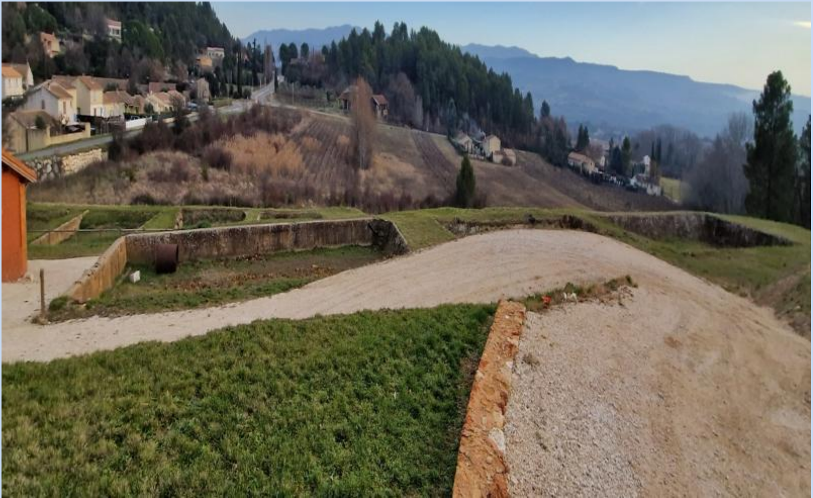
Un des 24 bassins en contrebas du bâtiment
