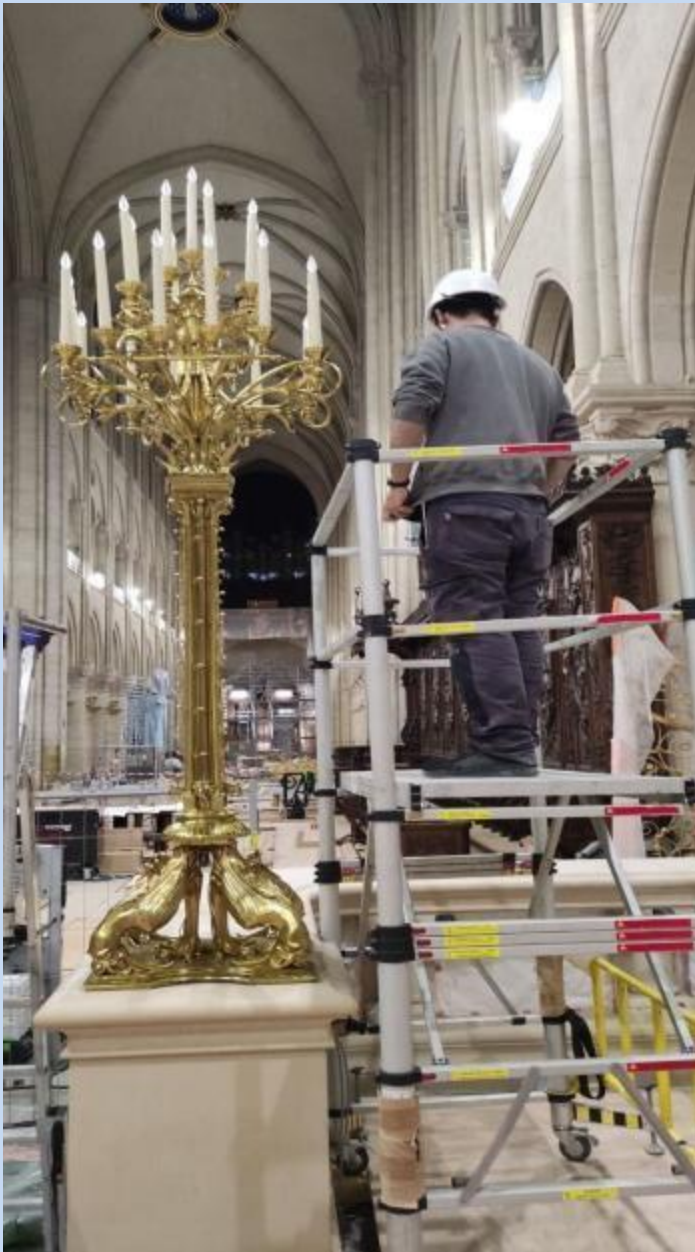
Installation d'un des candélabres restaurés (Photo Internet)
